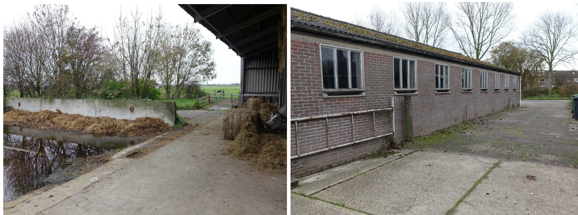
Figuur 4. Erfbeplanting bij open (metalen) kapschuur (links) en de betreffende stal (rechts) op het erf aan de Halerweg 11 te Schagen
