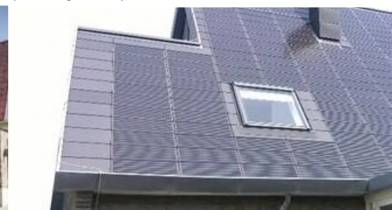
Geïntegreerde zonnepanelen op een huis in Callantsoog (Foto: Kees van der Leun)
