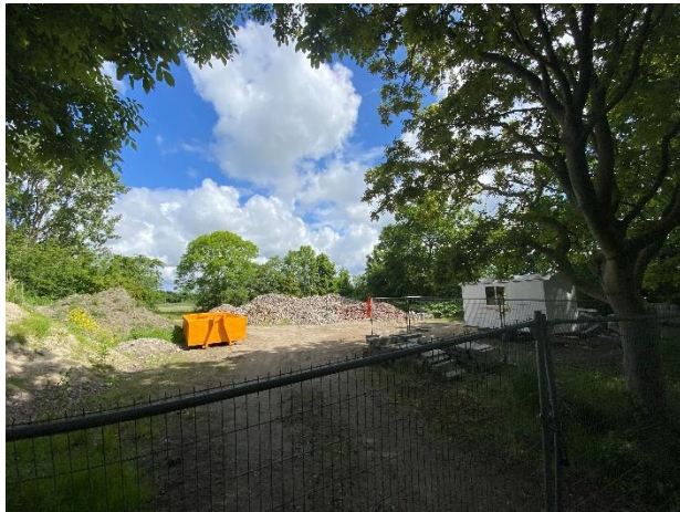
perceel 32 in gebruik als depot
