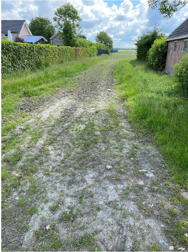
Betonresten ter plaatse van inrit Oostwal
