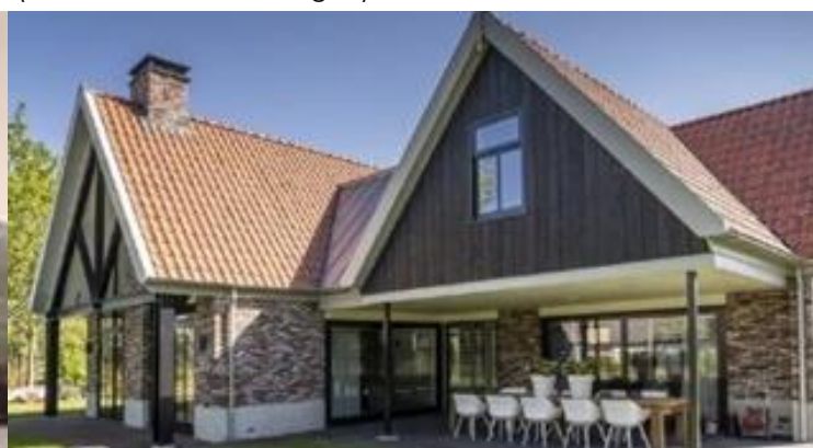
Voorbeeld dorpsse vrijstaande woning. Geleding bouwmassa en kapsamenstelling geeft kleinschaligheid (Bron: Breddels.nl)
