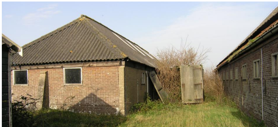
Schuur met golfplaten dak (16 oktober 2017)
