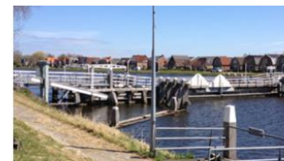
Noordhollandsch Kanaal - Vlotbrug
