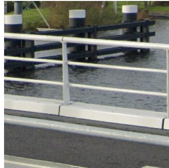
Afbeelding 4.23 Verzonken voetconstructie leuningwerk in opgaande brugrand (Prinses Amaliabrug, Krommenie)
