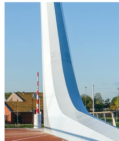
Afbeelding 4.17 Minimaal zichtbare naadconstructies bovenbouw, Joop van der Reijdenbrug (Duyfrak, Katwijk)
