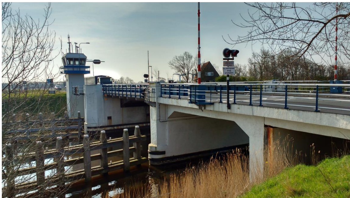
Afbeelding 1.1 Bestaande Stolperbasculebrug
