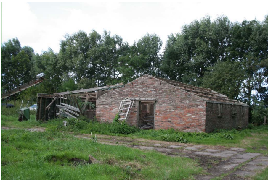
Eén van de schuren zonder een dak in het plangebied.
