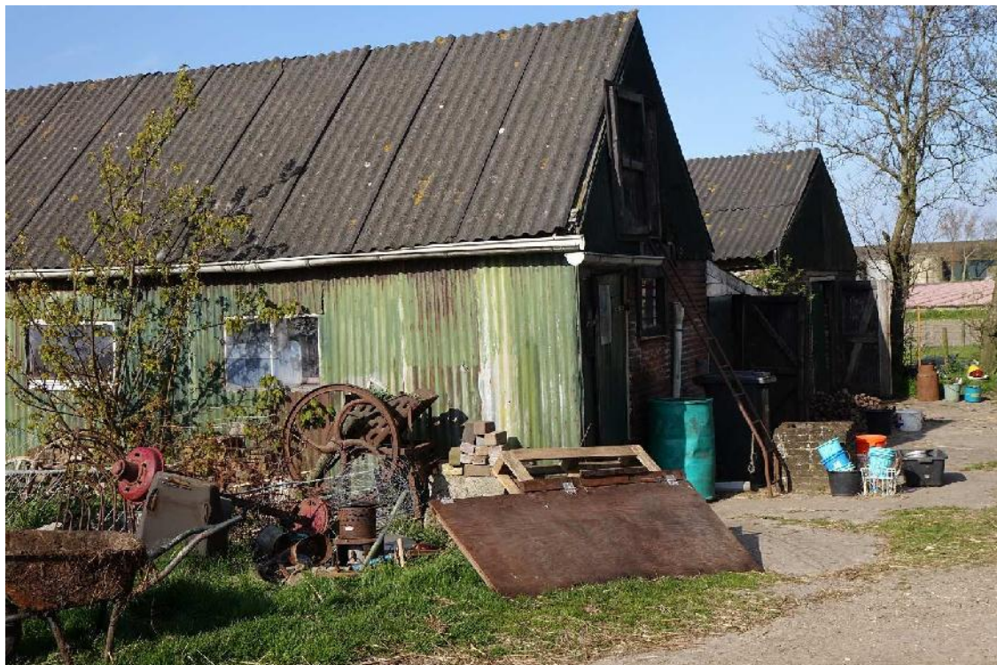
Figuur 3. Achterzijde van beide schuren op het erf aan de Belkmerweg 3
