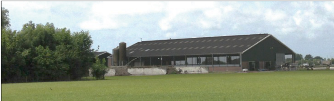
Afbeelding 4.4: Sleufsilo's op planlocatie gezien van de Korte Belkmerweg
