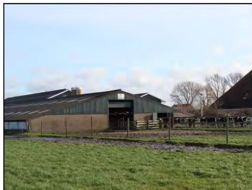
Foto 3. Te slopen stal in fase 2
