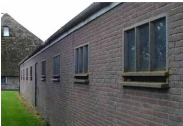
Ligboxenstallen, zicht vanaf perceel richting stolp
