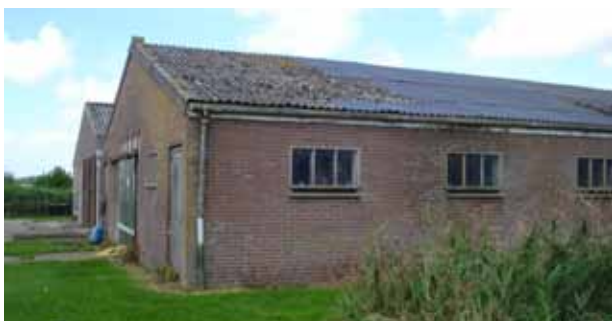
Ligboxenstallen, zicht vanaf de Grote Sloot
