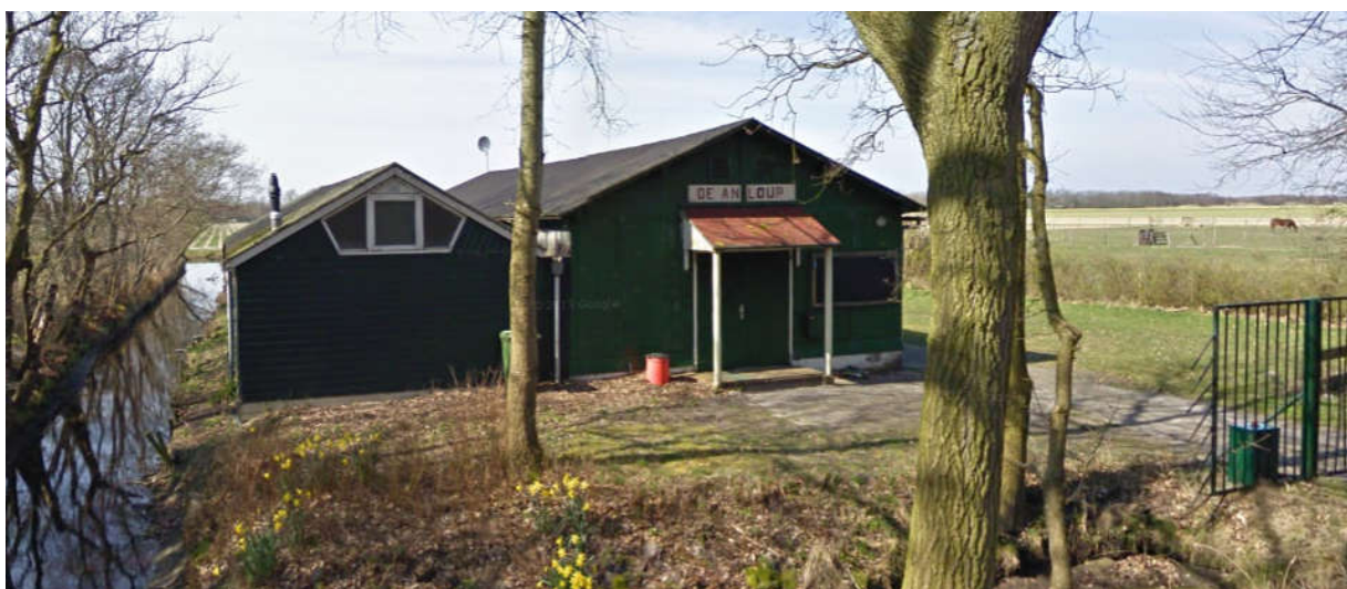
Afbeelding 3: Foto van het inmiddels gesloopte verenigingsgebouw
