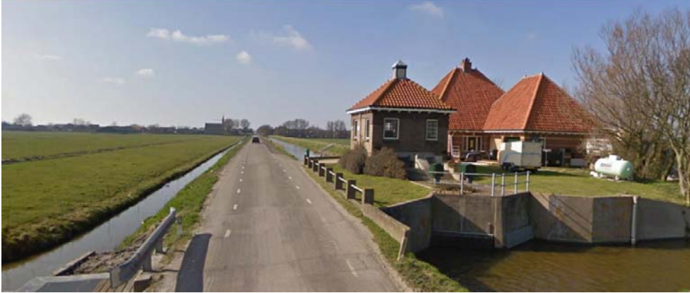
Figuur 6. Bestaande bebouwing bij de locatie voormalig gemaalgebouw
