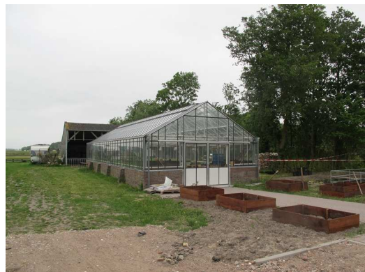
Afbeelding 6. Voormalige koeienstal omgebouwd tot kweekkas.
