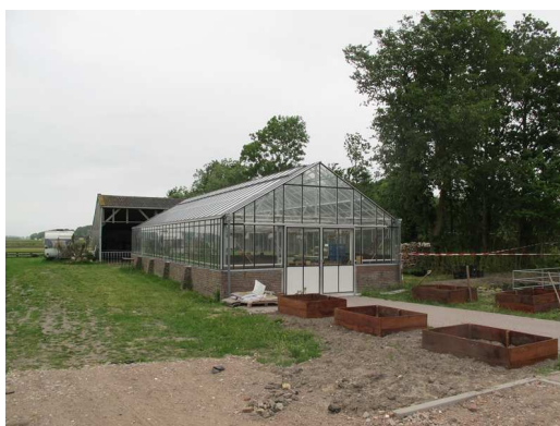
Afbeelding 6. Voormalige koeienstal omgebouwd tot kweekkas.
