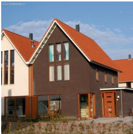
Lintbebouwing verder van de weg af is hoger
