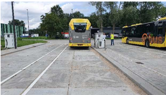
Remise Nieuwegein (perrons met stekkerladen)
