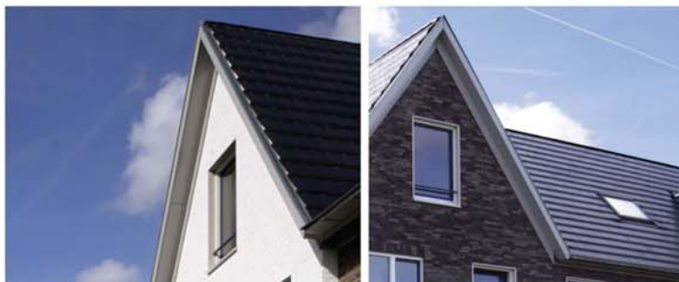
Detailering overstek. Minimaal 30cm (excl. goot).
