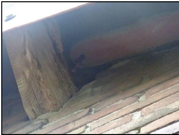
Afbeelding 6: Ruimte tussen de muur en de dakplaten bij de dakrand
