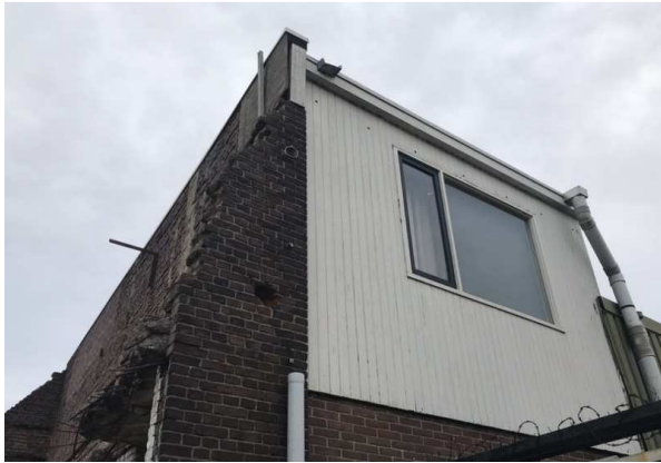
Figuur 11. Detail van gebouw die aan de oostkant grenst, aan de plaats waar de gebouwen gesloopt zijn.
