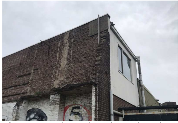
Figuur 12. Detail van gebouw die aan de oostkant grenst, aan de plaats waar de gebouwen gesloopt zijn.
