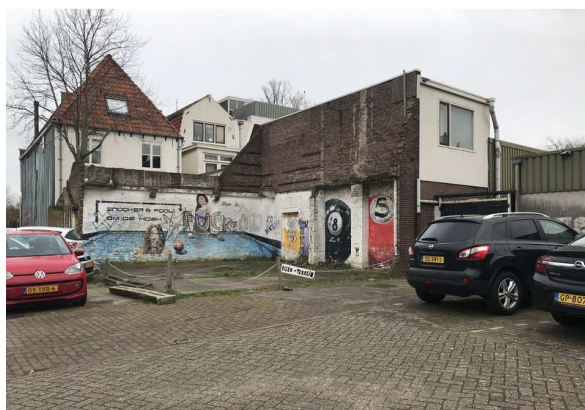
Figuur 6. Gebouwen die aan de oostkant grenzen aan de plaats waar de gebouwen gesloopt zijn.
