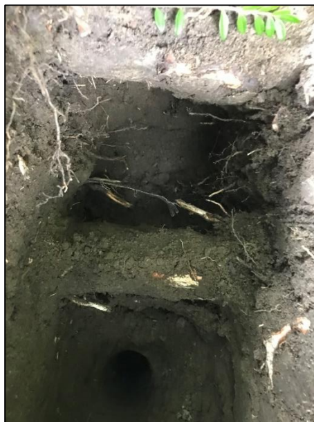
Stabiliteitswortel bij profielkuil 2
