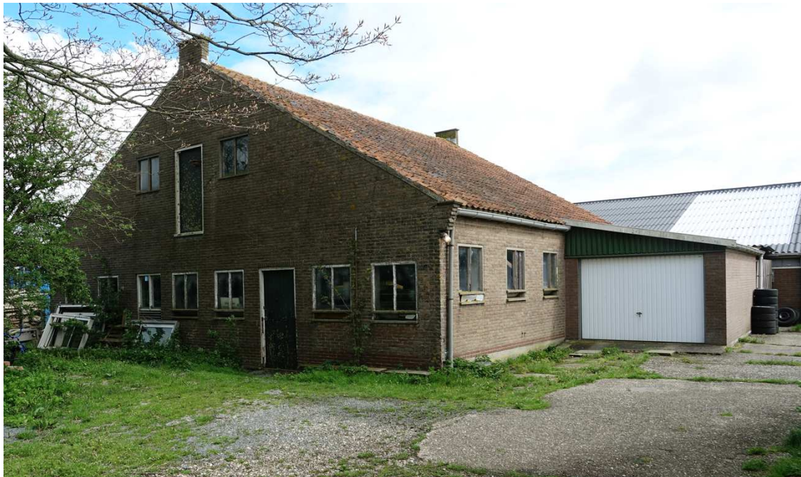
Figuur 2. De te slopen schuur met daar achter het te slopen deel van de loopstal.
