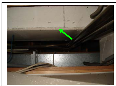
Foto 12 Asbest niet aantoonbaar
