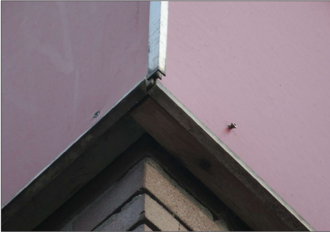
Afb 12: Dakrand aangrenzende flat sluit strak aan op het gevelmetselwerk
