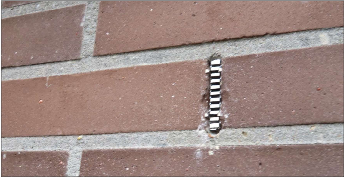
Afb 10: Structureel zijn bijenbekjes toegepast
