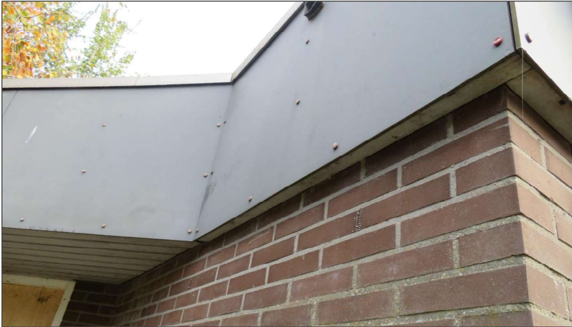
Afb 8: Gevelaansluitingen dicht
