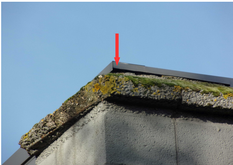
voorbeeld van toegang tot (waarschijnlijk) een holle ruimte onder het dak
