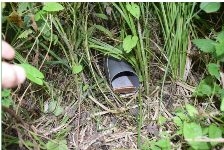
Plaatsen van een sporenbuis.
