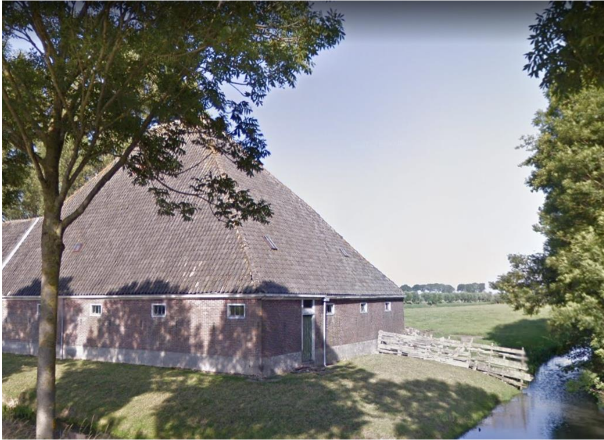
Figuur 8- Bestaande stal Hobrederlaan 1
