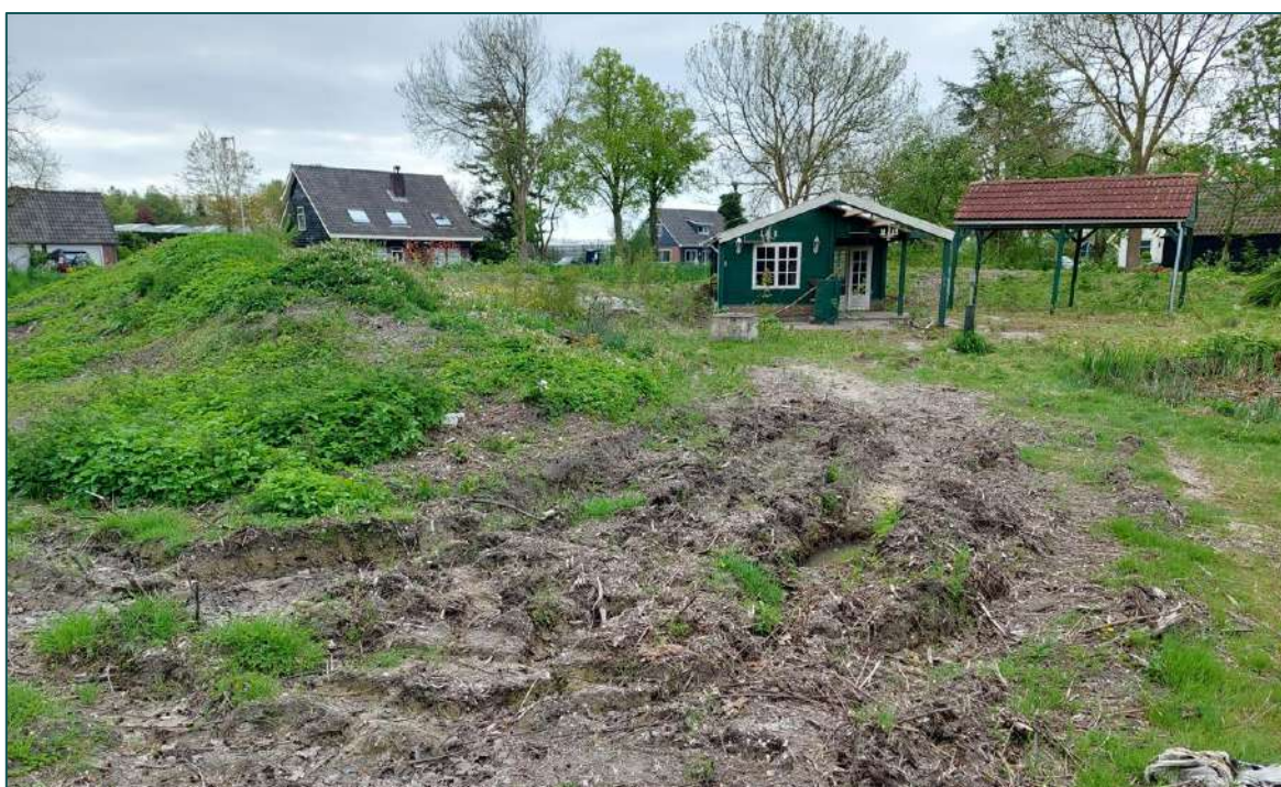
Figuur 1.4 Op het tuinperceel is een tuinhuis en een carport gesitueerd. De tuin is geruime tijd niet onderhouden.
