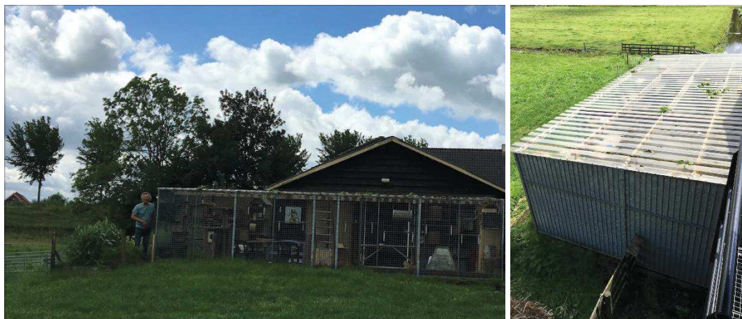
Figuur 3 gesloopte buitenverblijven katten, bron: eigen fotomateriaal
