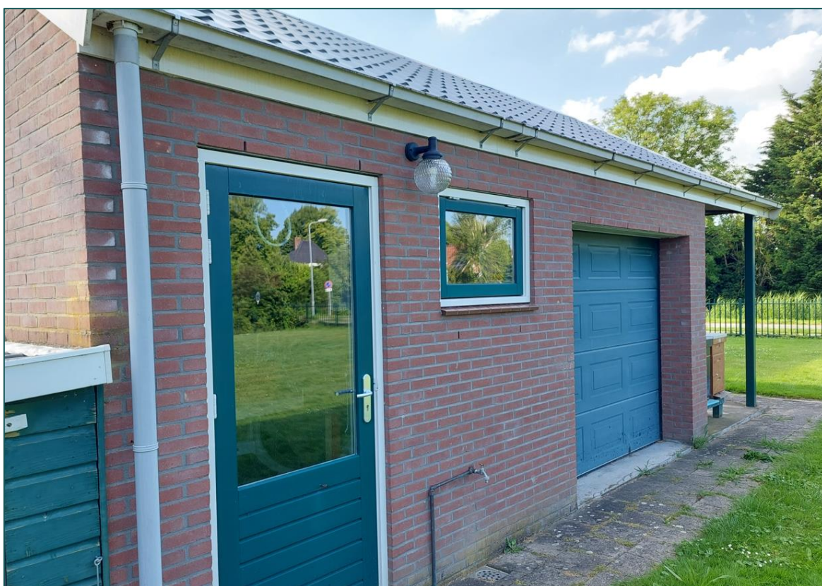
Figuur 2 De te slopen schuur op de planlocatie.
