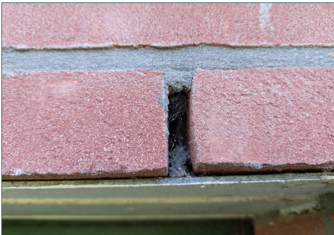
Figuur 3 Vele open stootvoegen vertonen spinnenrag.
