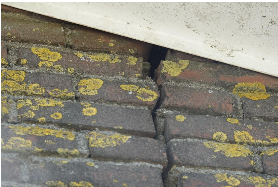
Figuur 4-7 Ruimte achter de dakbeschoeiing waar enkele vleermuizen zich kunnen vestigen.
