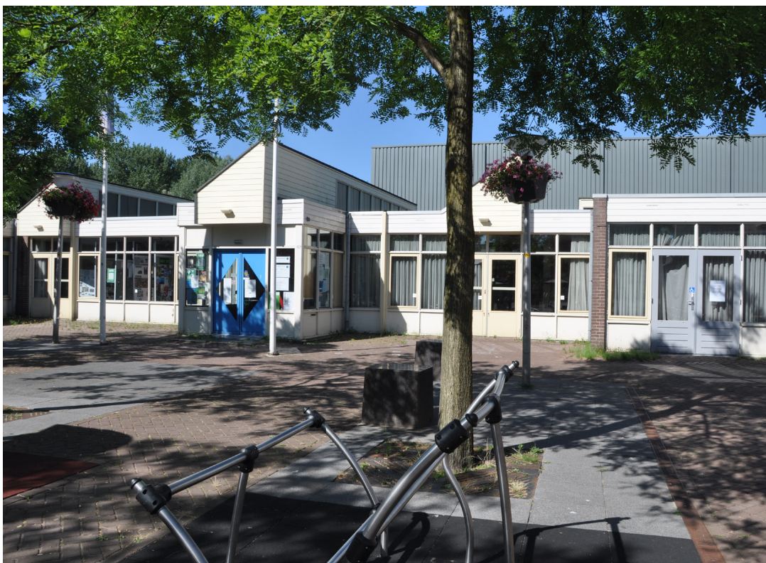
De te slopen bebouwing.
