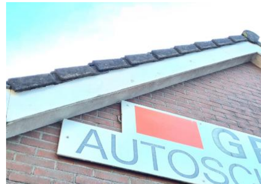
Figuur 5: Detail gevel voorzijde
