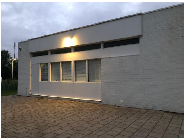
Figuur 4. Westzijde van het gebouw.
