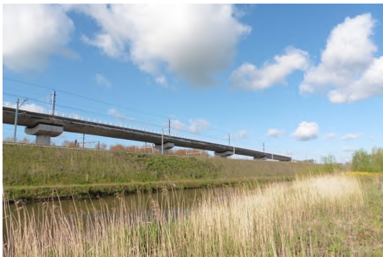
Foto 2: spoorviaduct met op de voorgrond de watergang aan de zuidzijde van het plangebied (kijkrichting zuidwest)
