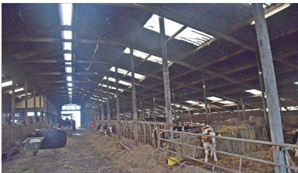
De balkenconstructie bied potentie voor nestgelegenheid Huismus.
