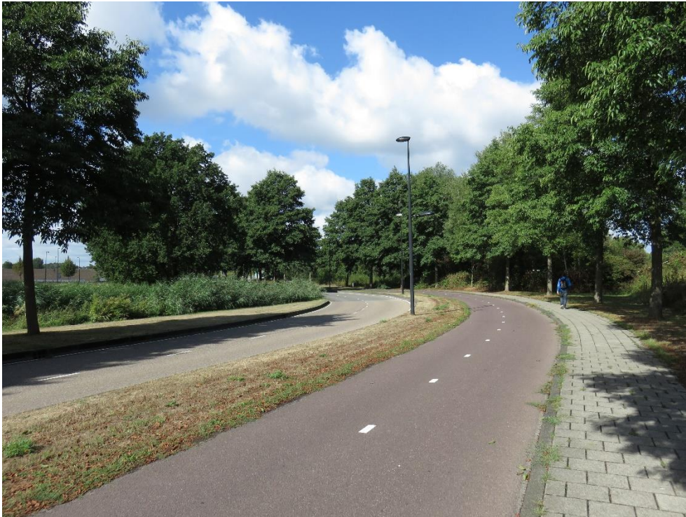
Overzicht van de noordzijde van het plangebied
