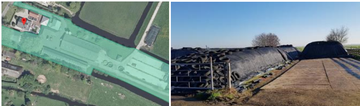
Afbeelding 3 : Foto bestaande bedrijfsbebouwing en de bestaande kuilplaten
