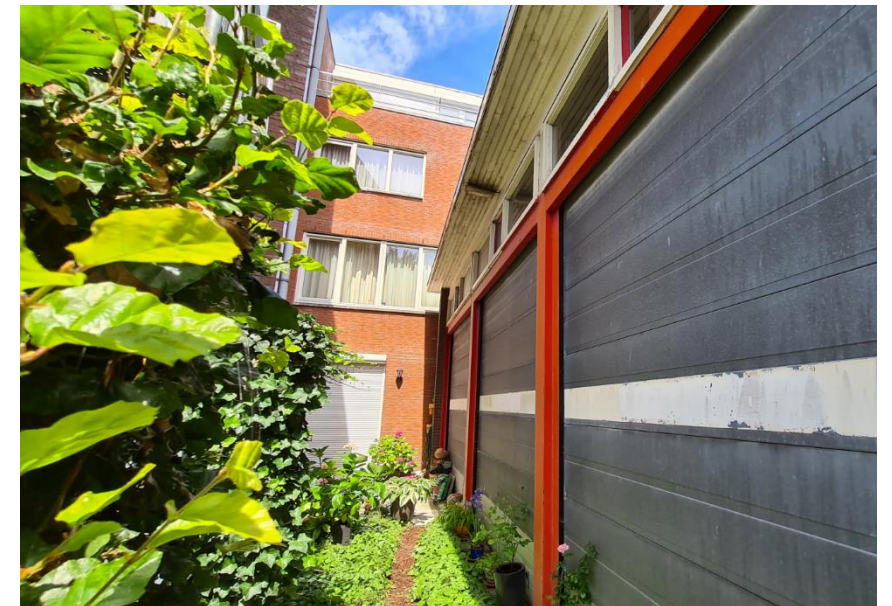
Figuur 7: Achtergevel bebouwing
