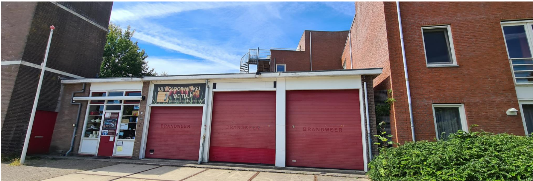
Figuur 3: Voormalige brandweerterein gezien vanaf de Prinses Beatrixlaan
