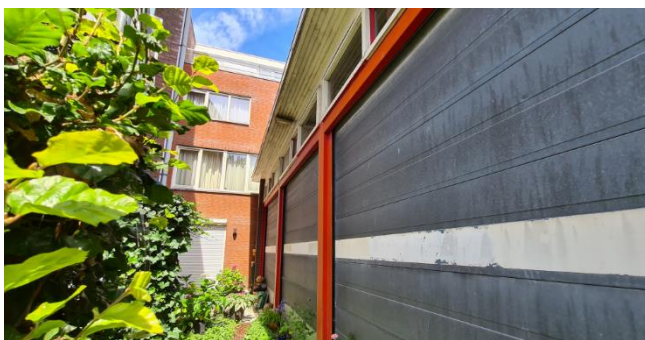
Figuur 8: Achtergevel bebouwing
