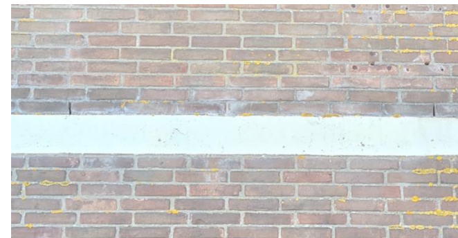
Figuur 11: Kleine smalle openstoot voegen in de toren
