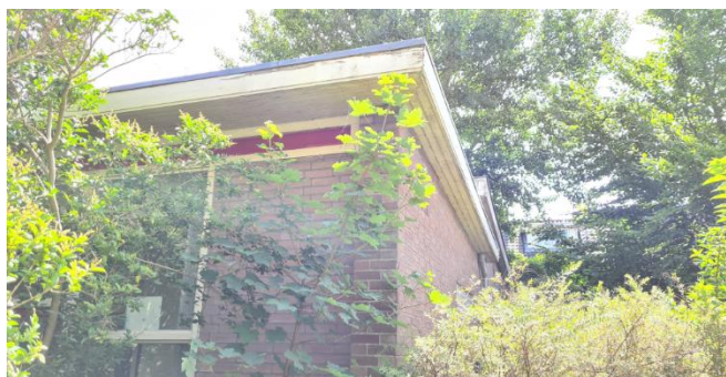
Figuur 7: Achterzijde bebouwing
