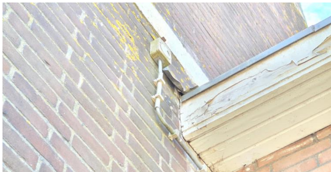
Figuur 13: Stukje loshangend loodslab
