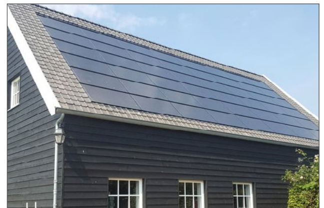
Zonnepanelen architectonisch onderdeel van het dakvlak
