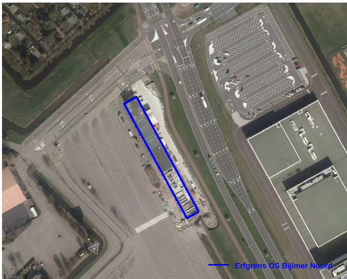
Figuur 1: Luchtfoto van onderstation Bijlmer Noord
