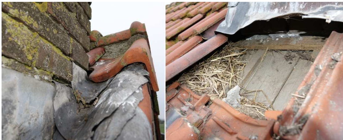
Figuur 3. Het dakbeschot onder het loodwerk is beperkt toegankelijk voor vleermuizen en biedt geen toegang tot een (open) zoldering. Ook sporen die wijzen op een verblijfplaats van vleermuizen zijn niet aangetroffen onder de loodslabben.
