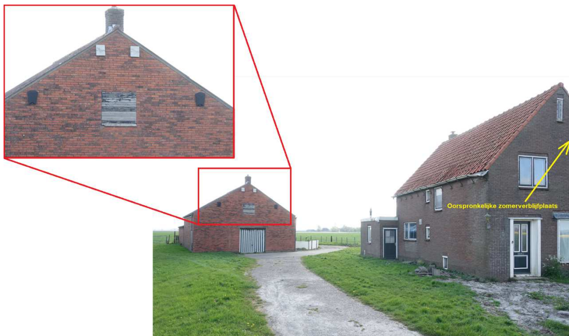
Figuur 5. Vier alternatieve vleermuiskasten aan de westgevel van de achtergelegen (te behouden) schuur aan de Tropweere 16 op nog geen 25 meter van de oorspronkelijk zomerverblijfplaats.
