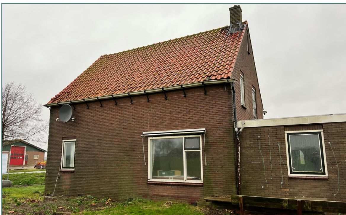
Figuur 2 Onder de eerste rij dakpannen kunnen huismussen een nestlocatie bereiken. Via scheefliggende dak- en kantpannen kunnen vleermuizen en huismussen een verblijfplaats/nestlocatie bereiken. Daarnaast kunnen huismussen via de eerste rij dakpannen de dakruimte bereiken.
