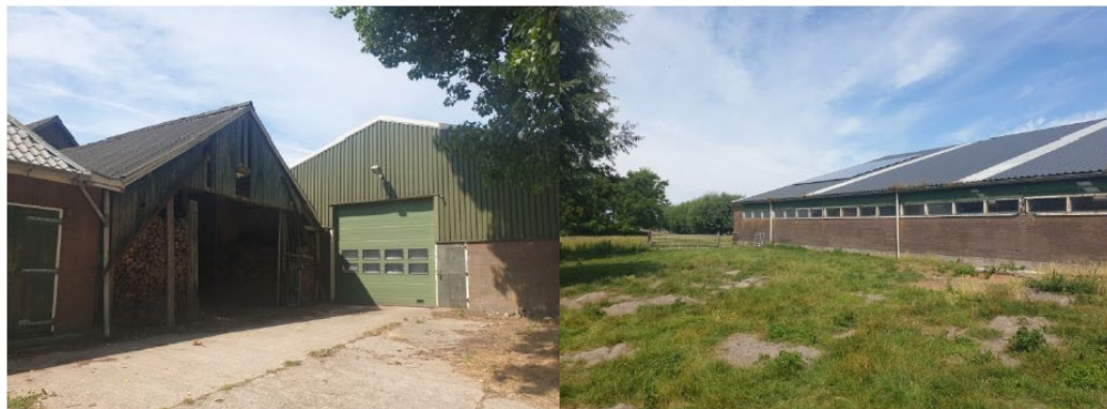
Zicht op voormalige stal en huidige loopstal
