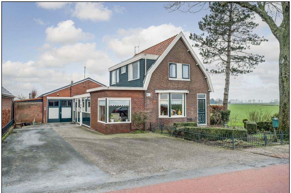
Afbeelding: de foto geeft een impressie van de bestaande bebouwing ter plaatse van het plangebied.
