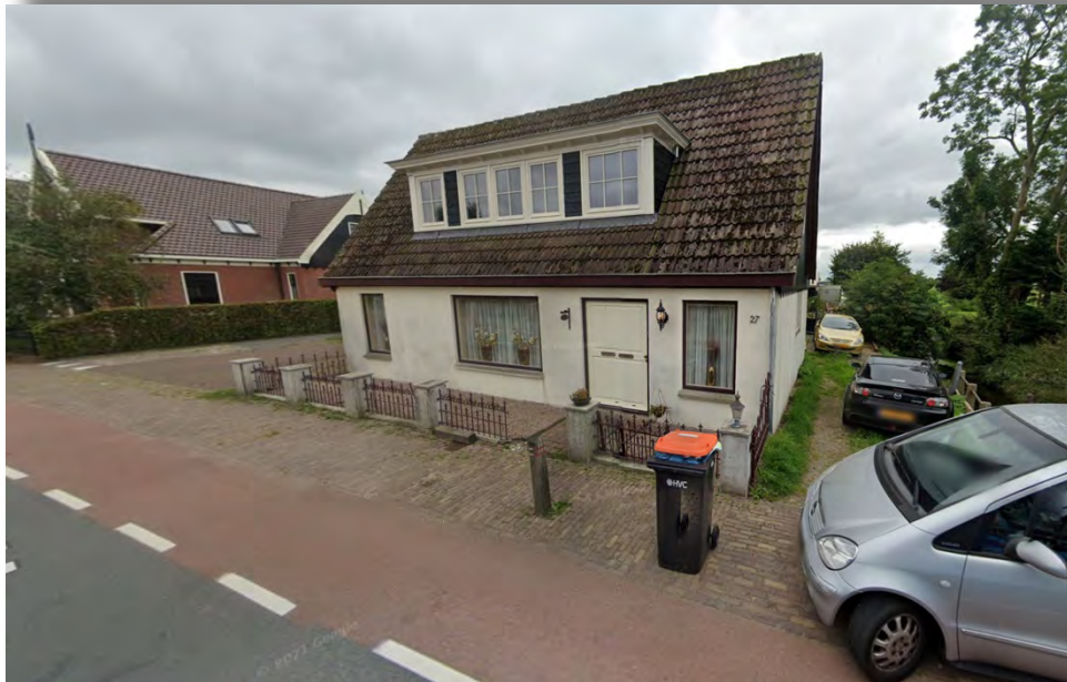
Bestaande situatie Wadway 27 Spanbroek
