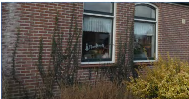
Foto 25 en 26 muren zonder open stootvoegen.
