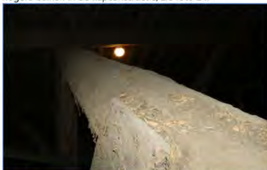
Foto 24 een van de hoger gelegen balken in de kap
