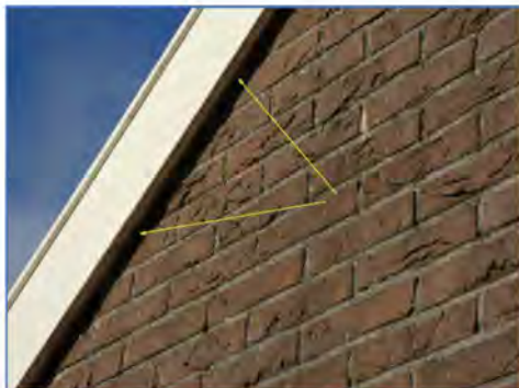
Foto 27 afsluiting windveer op gevel met afdichtingslat
