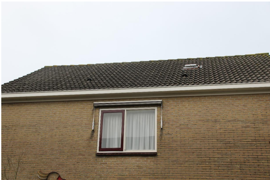
Dak van woonhuis
