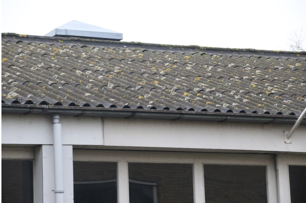
Dak van loods
