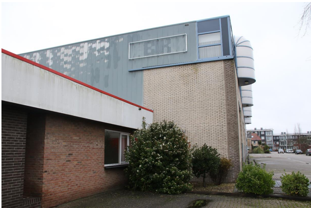
Gemetselde muren (links kantoorgedeelte) en fabriekshal
